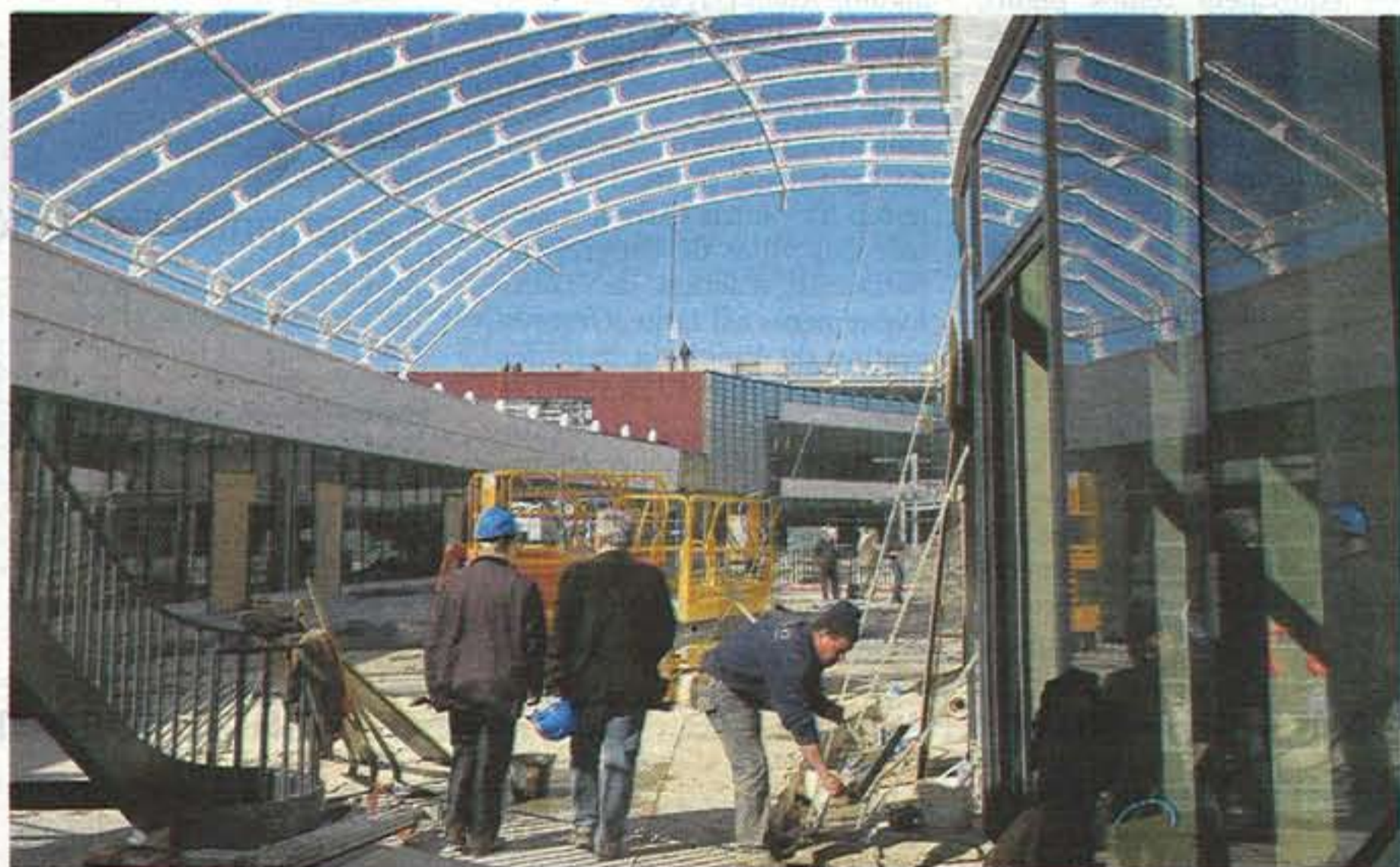
Un grand escalier (à gauche sur la photo) permet d'accéder au niveau supérieur de la galerie.
