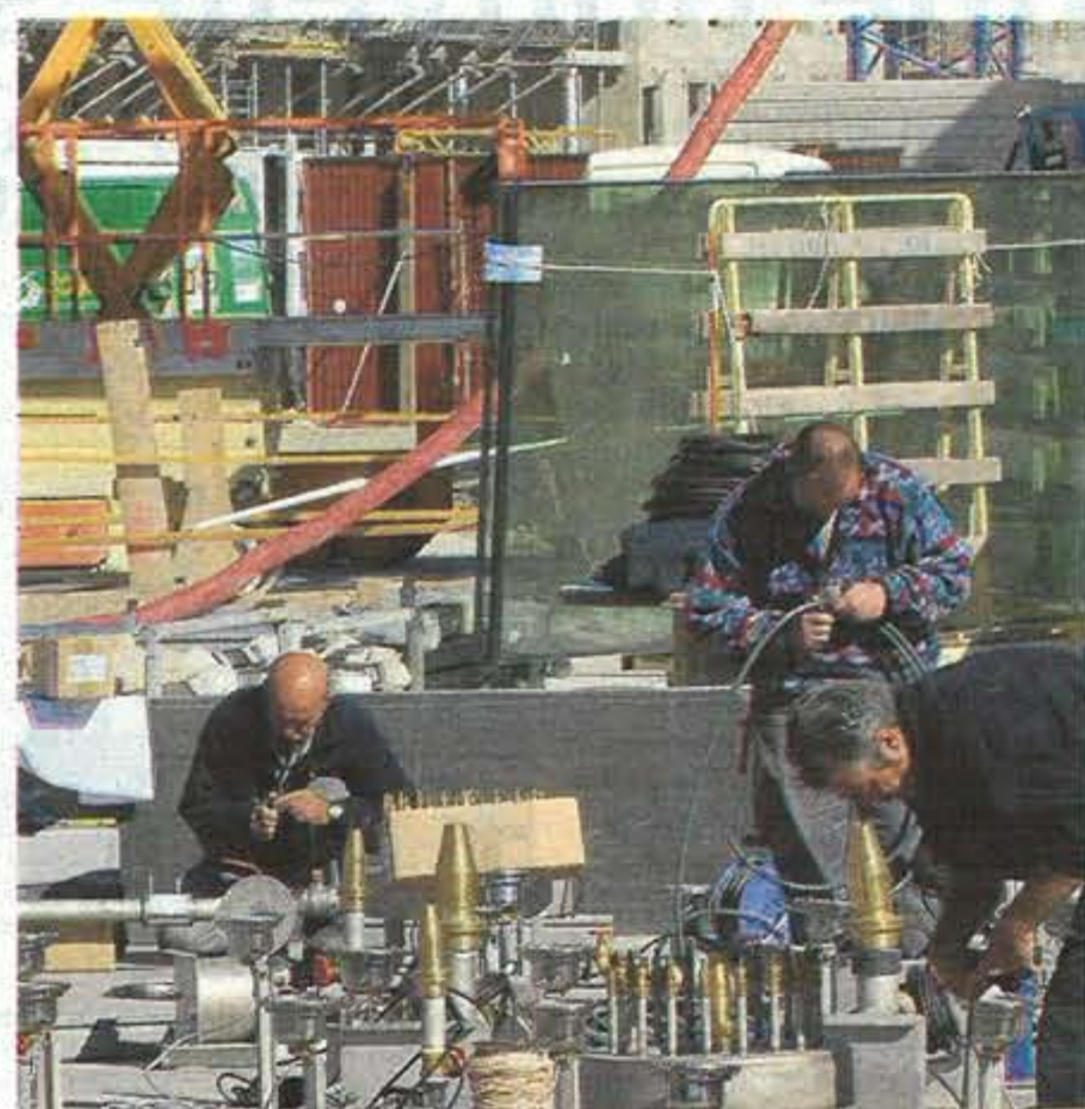
L'installation des jeux d'eau, au milieu de la galerie : une véritable attraction qui sera visuelle et sonore.
