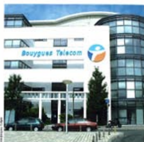
(ci-dessous) L'implantation de Bouygues Telecom : une étape essentielle dans le développement du quartier.
